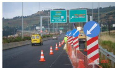
Εικόνα 4.2: Προστατευτικό πλέγμα ασφαλείας για περιοχές εκτέλεσης έργων
